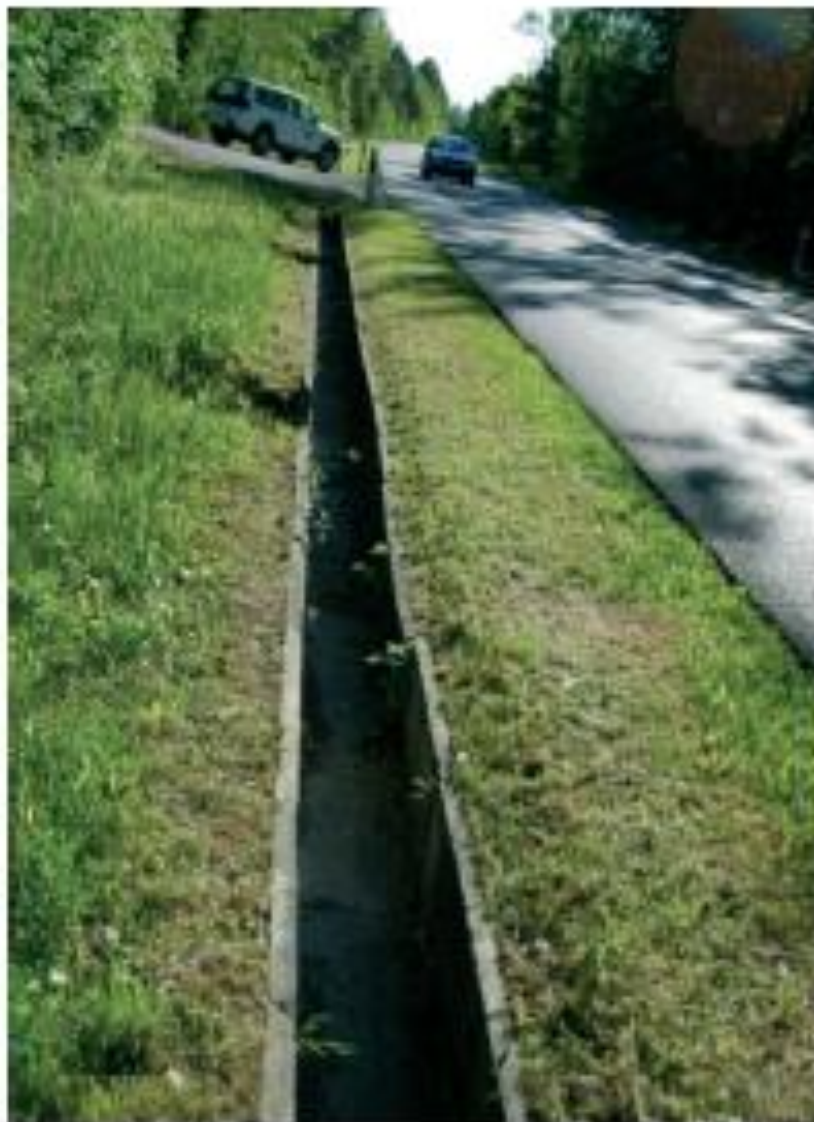
Fig. 5 - Canaletta per intercettare gli antipi in arrivo dal bosco adiacente la strada
